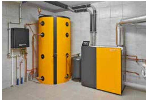
Holzpelletkessel mit Vorratsbehälter und Pufferspeicher, zur Leistungsregelung. Foto: ETA
