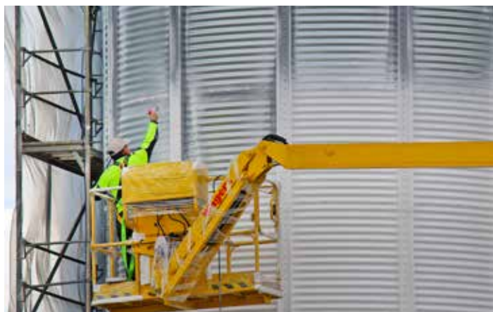
Aufbringen der finalen Farbschicht auf der Außenhülle des Silos in Oberlosa nach der zweilagigen Abdichtung aller Öffnungen
