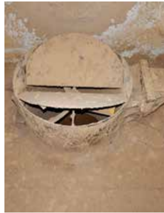
Bewegliche Teile der Stellklappen sind durch Staub und Feuchtigkeit sehr störungsanfällig.
