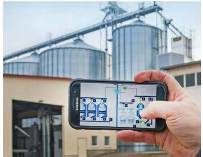
Moderne Getreidelager lassen sich auch per Smartphone überwachen und steuern.
