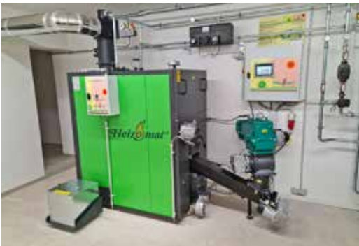
Bei der Holzhackschnittelfeuerung erfolgt die Beschickung des Kessels automatisch. Foto: Heizomat
