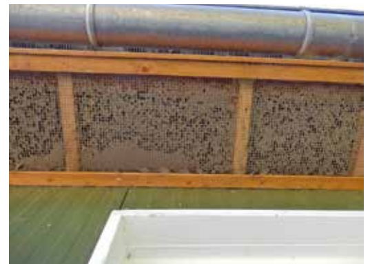
Verschmutzte Traufgitter erhöhen den Druckverlust enorm.
