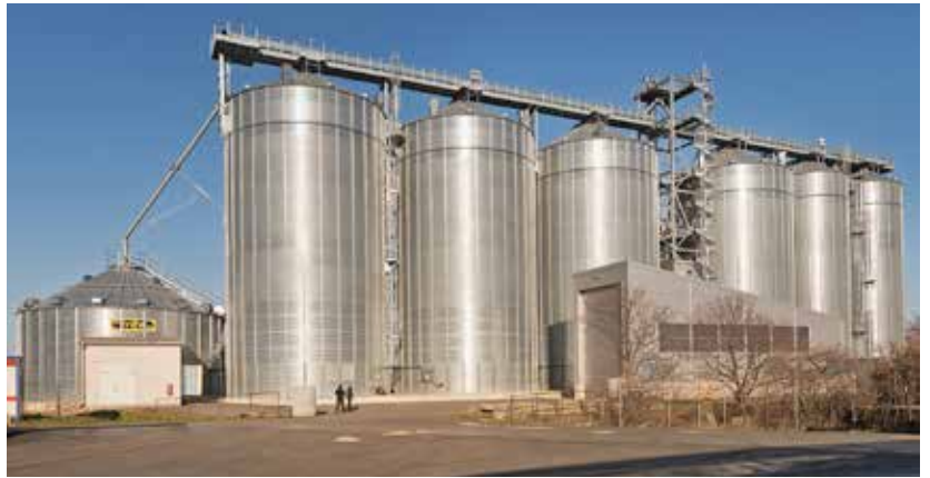
Getreidelager sollten gegen das Eindringen von Schädlingen geschützt und möglichst hermetisch abgeriegelt werden. Die Verluste durch Schadinsekten im Lager werden auf etwa 4 % geschätzt.
