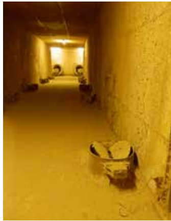
Mit der Zeit sammelt sich einiges an Staub im Zentralkanal an. Es empfiehlt sich eine jährliche Reinigung.
