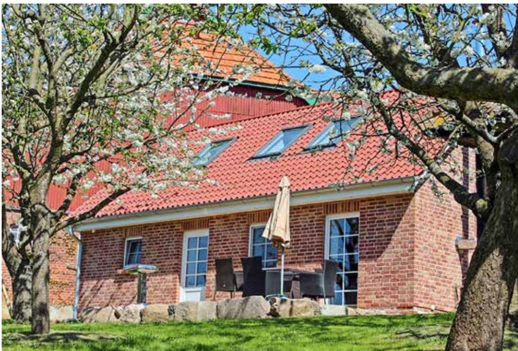
Ein alter Hühnerstall konnte durch Erhalt der statisch relevanten Holzkonstruktion und des gesamten Mauerwerkes zu einem attraktiven Wohnraum umgenutzt werden. Neue Fenster und Türen sind bei Umnutzungen unproblematisch.
